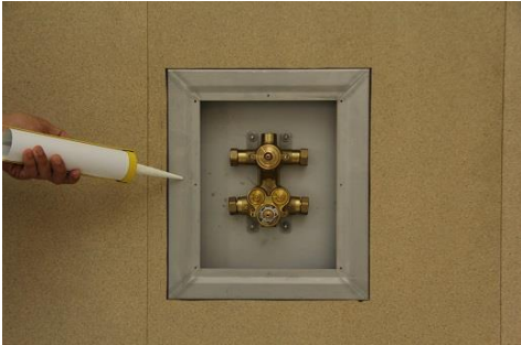
2 - Applicera ARDEX SK 105 MS på skåpets fläns. Stryk ut med fintandad limspidare.
