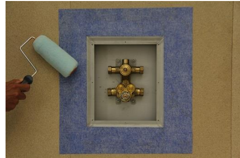
5- Applicera Adda Membran på manchetten och övrig väggyta.
