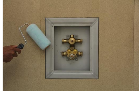
3 - Applicera Adda Membran på övriga väggytan som manchetten skall täcka.
