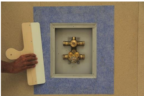
4- Stryk ut manschette noga och säkerställ så att inga veck eller luftblåsor uppstår.
