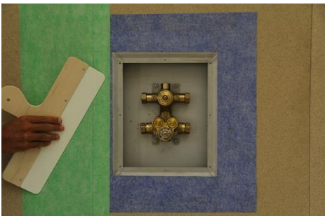
6 - Montera Adda Tätfolie överlappa manchetten med minst 5 cm.
