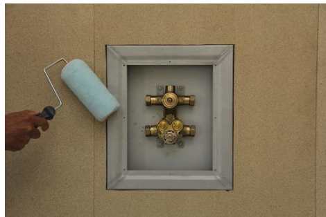
3 - Applicera KD+Tätmembran alt. KD+ 2K Folielim på övrig väggyta som manchetten skall täcka.
